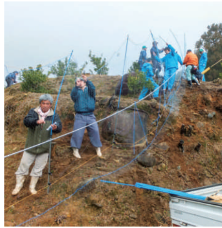
侵入経路マップを活用し、被害に遭いやすい場所から侵入防止柵を設置する
