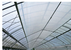
内張りビニール
