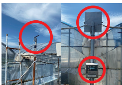
自動開閉装置(モーター・雨センサー・リレーボックス)
